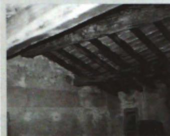
Il soffitto ligneo non ha più funzione di sostegno del tetto (che è stato rifatto con altri materiali), ma di semplice rivestimento
