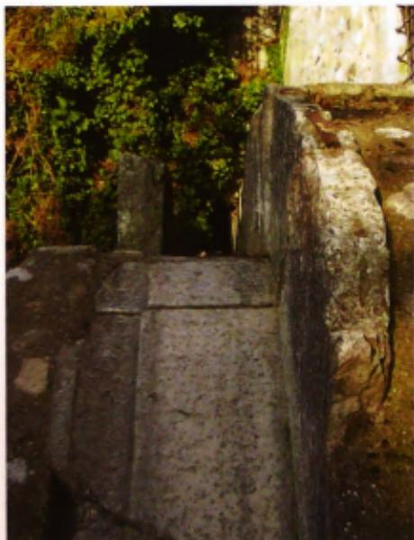
rittura di epoca antecedente. Questi due grandi blocchi servivano per sostenere il battente con cui, grazie alla forza dell'acqua, si batteva il ferro per forgiarlo. All'esterno è ancora visibile la posizione della ruota, il cui mozzo era posto in corrispondenza del punto all'interno dove si trovava il battente. Visibile anche la canalet-
