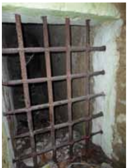
Via Antiche Mura - Un cunicolo interrotto da una grata, datato 1776
