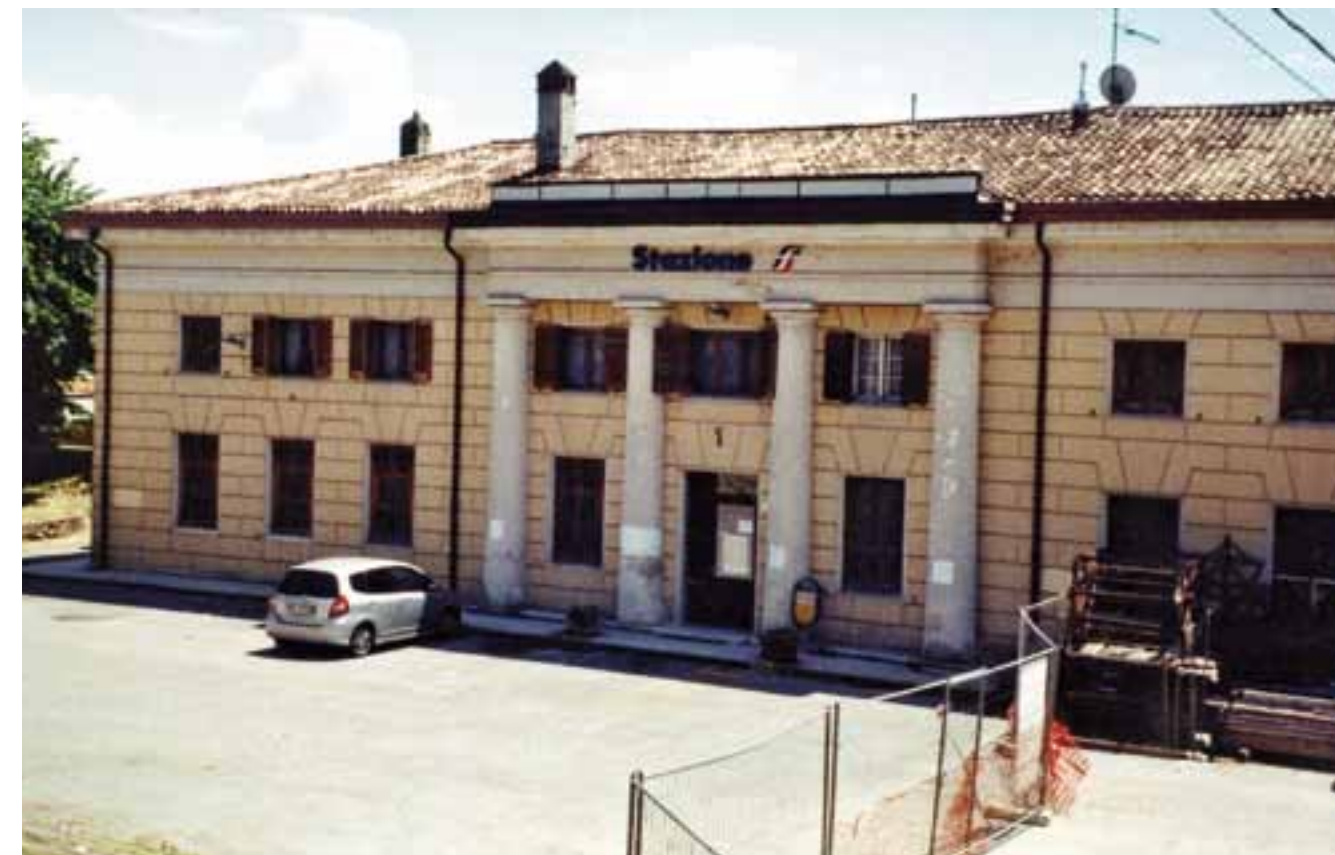
Lonato 2013 - La ottocentesca stazione ferroviaria di Lonato
