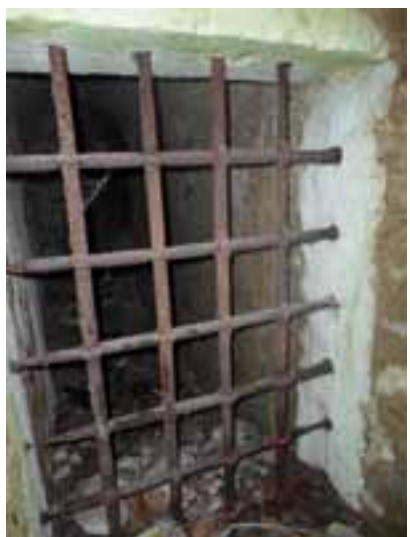
Via Antiche Mura - Un cunicolo interrotto da una grata, datato 1776
