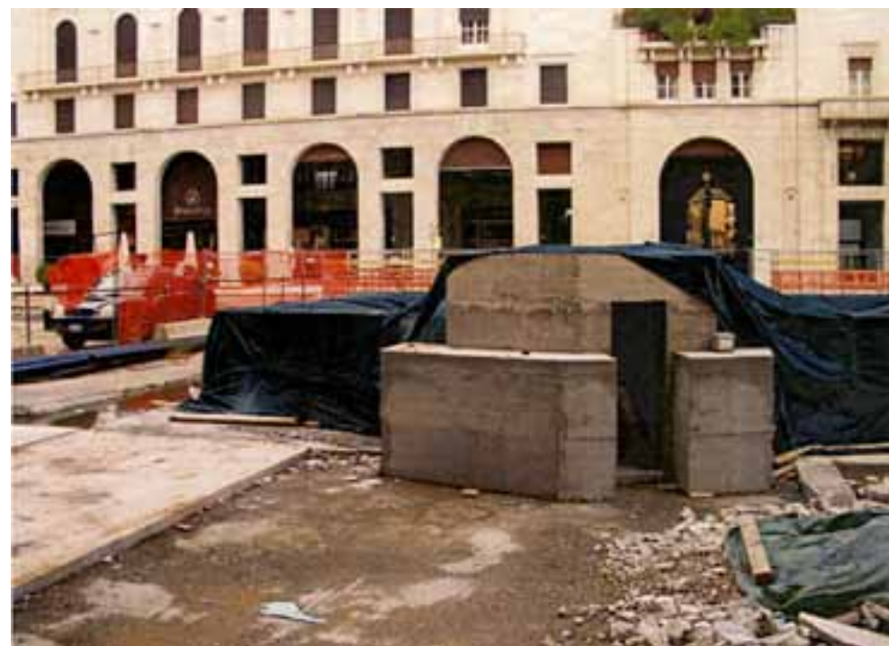
Brescia 2013 - Piedistallo in costruzione in Piazza Vittoria
