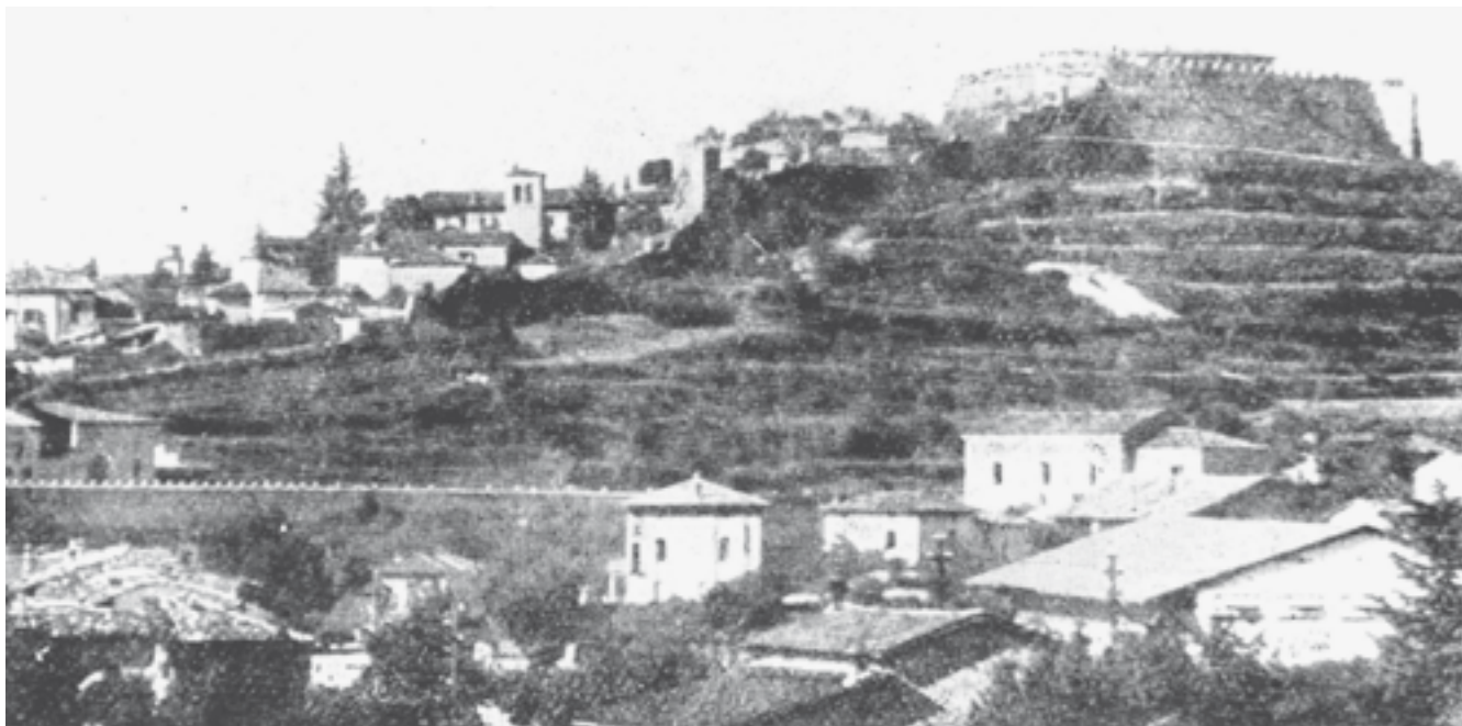
Panoramica di Lonato. Lungo il versante del colle della Rocca si vede chiaramente un grosso accumulo di materiale, probabilmente generato dallo scavo di una galleria interrata che lì aveva uno sbocco (foto Centro Documentazione Lonatese)
